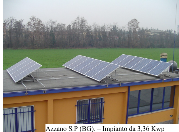
Azzano S.P (BG). – Impianto da 3,36 Kwp
